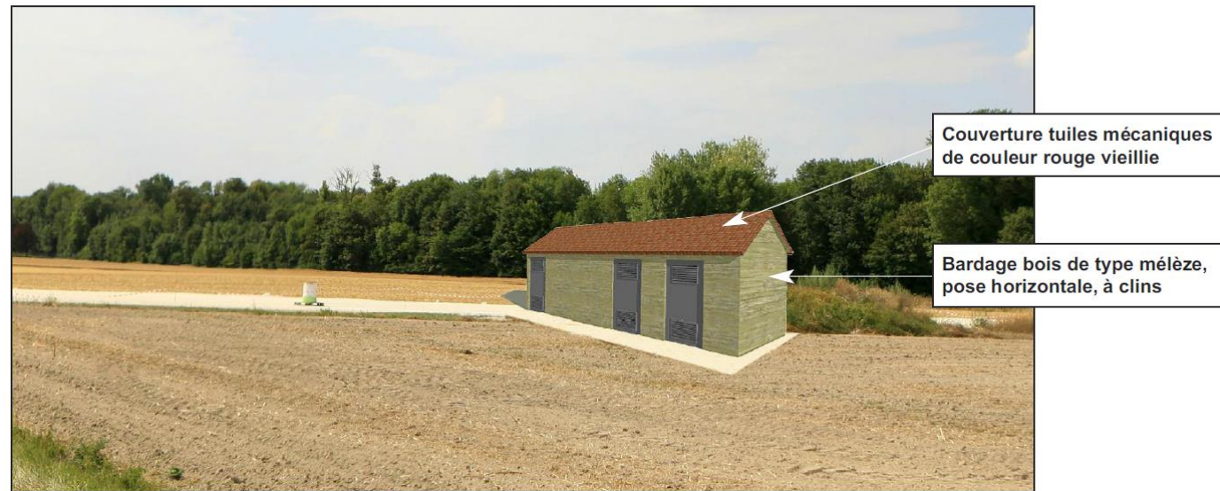
Figure 13 : Exemple de traitement des postes de livraison du parc éolien (Source : Lionel Jacquey)
